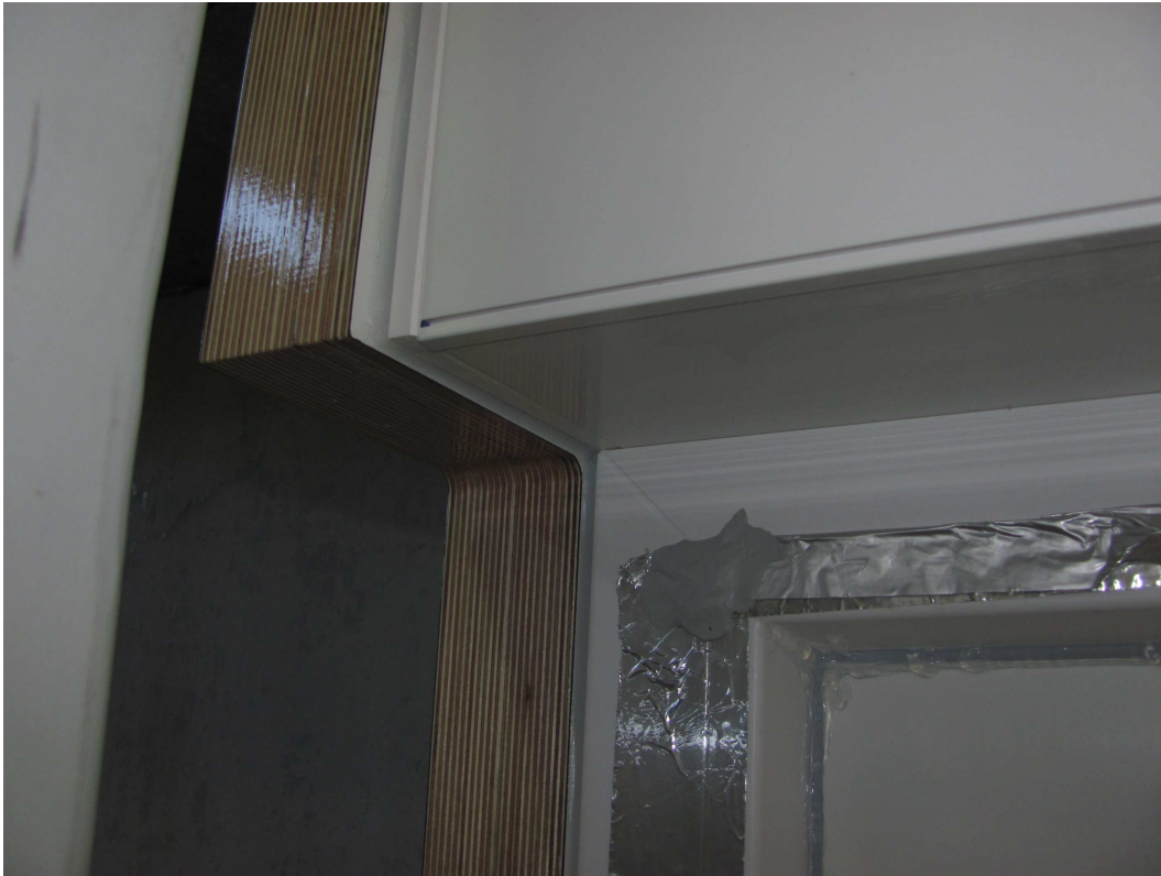
Bild 4 Prüfaufbau Messung der Luftdurchlässigkeit „Frontblende nicht überputzt“
